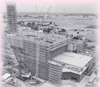
▲中央クリーンセンターの工事の様子（当時）
